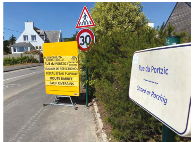
▲ Rue du Portzic. Création d'un réseau supplémentaire d'eaux pluviales, rénovation du réseau d'assainissement, suivie d'une réfection de la voirie.
