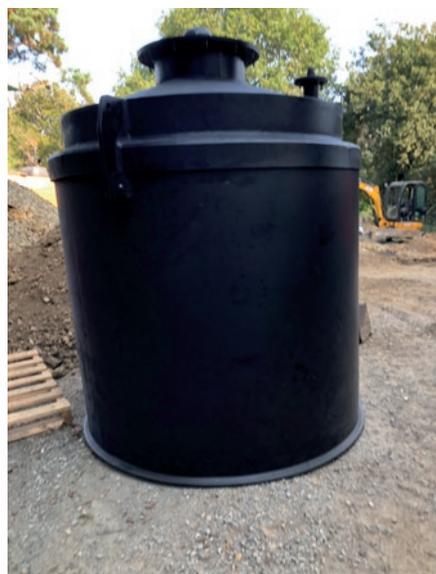
▲ Le nouveau poste est complété d'une installation de stockage et d'injection de Nutriox afin de limiter la formation de gaz H<sub>2</sub>S dans les réseaux.
