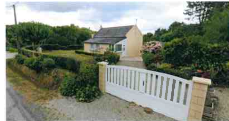
VUE 4 - Vue de la maison depuis le portail
