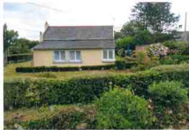
VUE 1 - Vue de la maison
