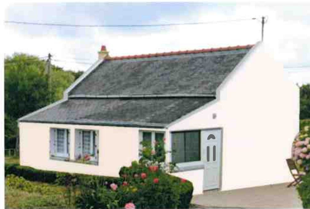
VUE 5 - Insertion visuelle du projet
